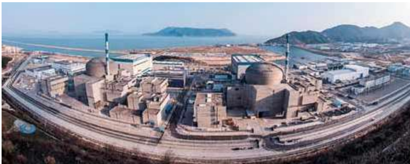
Centrale de Taishan (source : EDF 2019)
