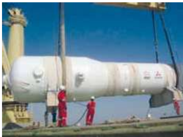
Transport d'un Générateur de Vapeur (GV). EDF envisage de recycler 70% de l'acier (environ 68 000 t pour les GV à traiter entre 2028 et 2055).
