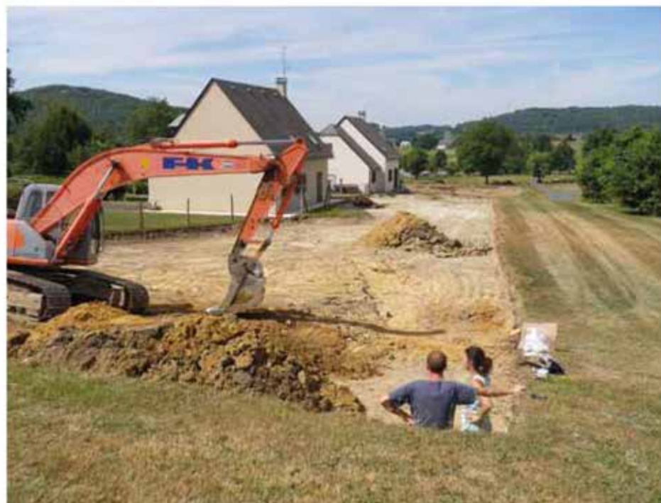
Lotissement communal à Saint-Pierre, construit sur des résidus radioactifs, en cours d'assainissement © photo : CRIIRAD 2010)
