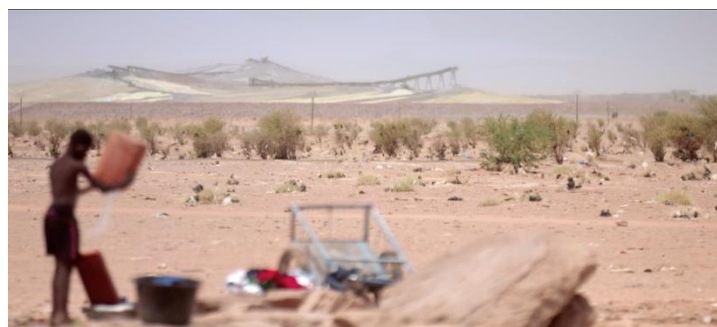
Résidus d'extraction de l'uranium à l'air libre à Arlit. © Premières Lignes 2021
