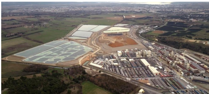
Usine ORANO de Malveysi : bassins contenant des effluents radioactifs solides et liquides. © Premières Lignes 2021
