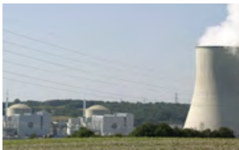
La centrale nucléaire de Civaux : à gauche, les deux réacteurs de 1 450 MWe ; à droite d'une des deux tours de refroidissement qui permettent de limiter les rejets thermiques dans la Vienne.
