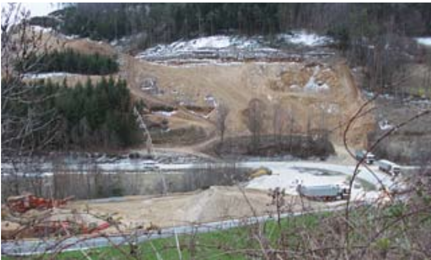
Le car scolaire, les concasseurs, la cribreuse et les camions... (Dép. 8) 08/04/08
