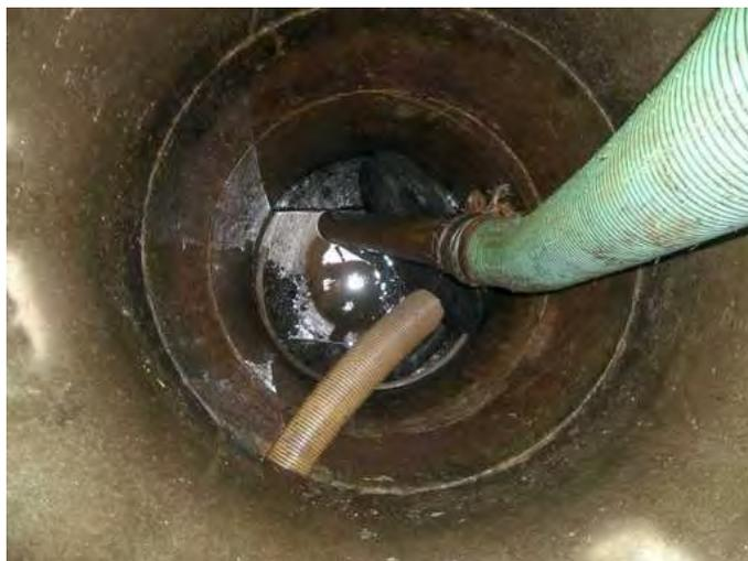
Photo 14 : Fond du « puits Gérémy » (à gauche tuyau de prise d'eau de la surverse qui alimente le bâchât)
