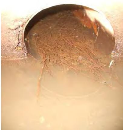
Photo 2 : Obstruction de la buse en provenance du bâchât par un réseau de racines d'arbres (2ème regard de l'alimentation Nord).
