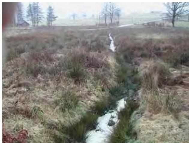
Photo 19 : Mission de mars 2006 : drain du Stand de Tir à l'intérieur du triangle routier- vue vers le sud. Débit soutenu alimenté par plusieurs drains en provenance du site minier / présence d'écume blanche.
