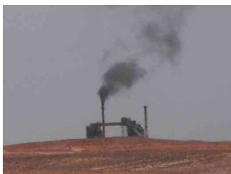
3375 / centrale thermique SONICHAR
