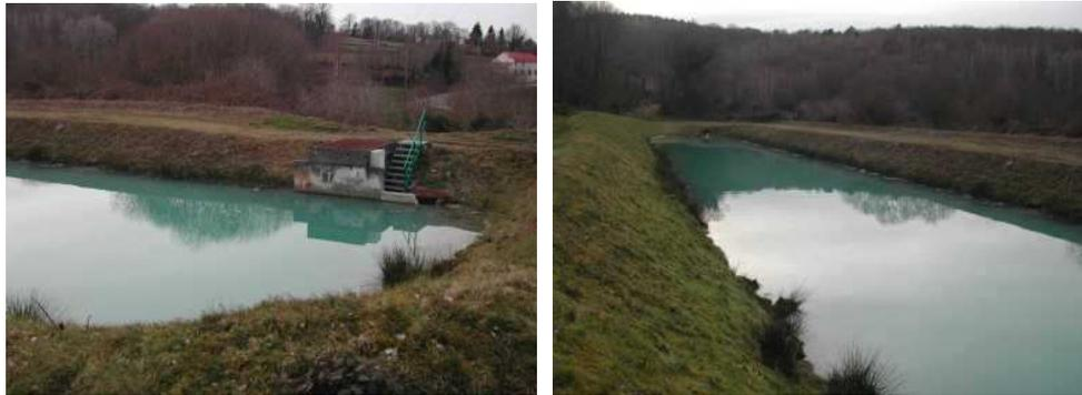
Bassin de décantation des effluents du site de Bellezane avant rejet dans le ruisseau des Petites Magnelles (CRIIRAD, mars 2004).
