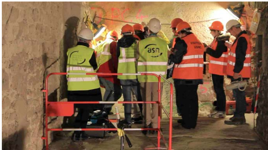
Photo : intérieur de la casemate TC1 durant les mesures (crédit photo : Marc Planeilles)
