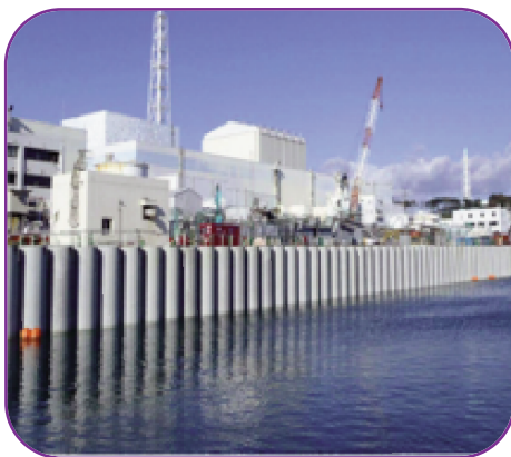
Le mur « imperméable » (Photographie : TEPCO, septembre 2015)
