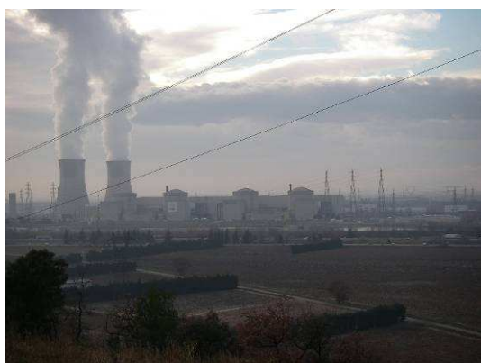
CNPE du Tricastin et tours de refroidissement de l'usine EURODIF – Photo CRIIRAD
