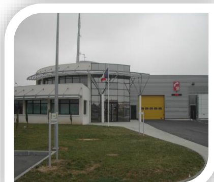
Caserne des sapeurs-pompiers de Romans
