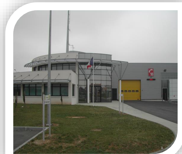
Caserne des sapeurs-pompiers de Romans
