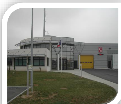
Caserne des sapeurs-pompiers de Romans
