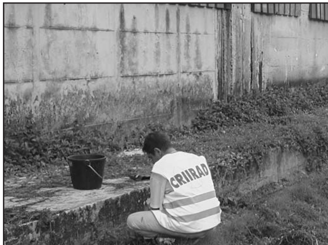
Echantillonnage de ciment poreux de l'ancien caniveau de récupération des eaux de lavage Ouest du toit du hangar destiné à protéger la population à Rikitea (Mangareva), le 8 octobre 2005. © CRIIRAD
