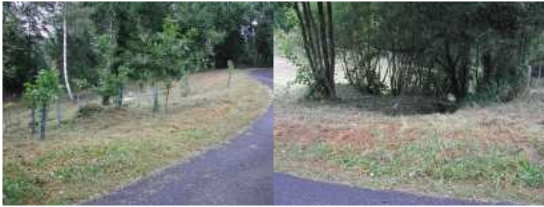
N° 20 et 21 : Drain en contrebas de la chaussée, vallon aboutissant au Combret.
