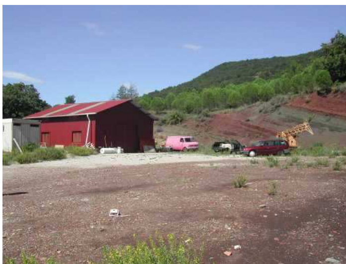
N°5: Présence de fragments actifs sur le carreau de la mine de Puech Bouissou / Photographie CRIIRAD du 15 septembre 2004 / Flux gamma DG5 au contact : 6 000 c/s, à 1 mètre du sol : 500 c/s.
