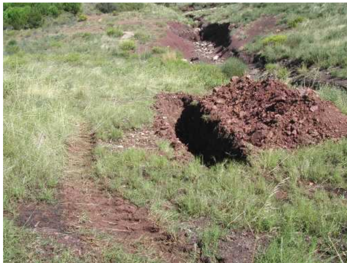
N°6: Tranchée creusée en contrebas du carreau de la mine de Puech Bouissou / Photographie CRIIRAD du 15 septembre 2004 / Flux gamma DG5 au contact : 4 000 c/s contre le parement intérieur.
