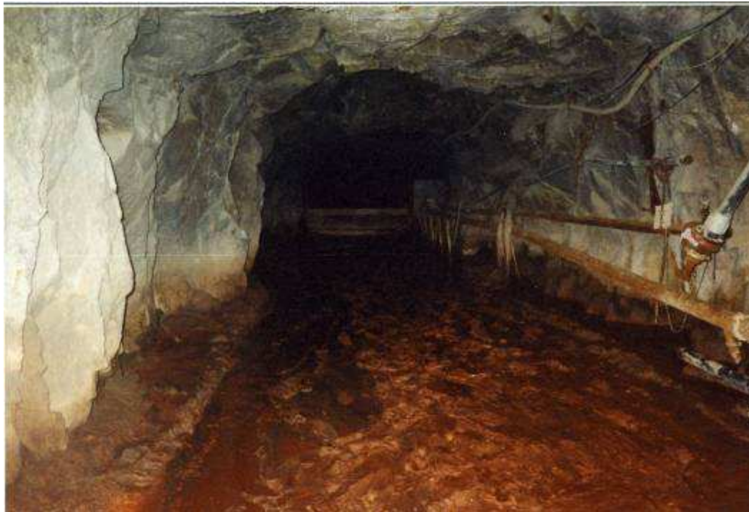
14 Accumulation de résidus dans une galerie sous le stockage de résidus de COGEMA à Bellezane (CRIIRAD, 1993).
