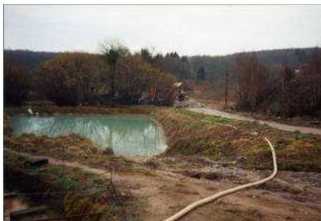
6 Bassin de décantation des eaux d'exhaure de la mine COGEMA de Puy de l'Age en Limousin (CRIIRAD, 1993)
