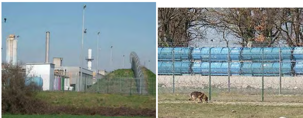
Usine FBFC CERCA (AREVA) de Romans (source : CRIIRAD)
