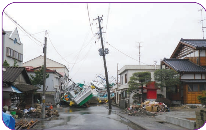
Dégâts causés par le Tsunami Photo de Christian Courbon - Mai 2011
