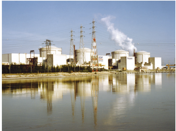
Centrale nucléaire du Tricastin : les vérifications post-Fukushima ont révélé que la digue ne résisterait pas (sur 400 m !) à un SMS
